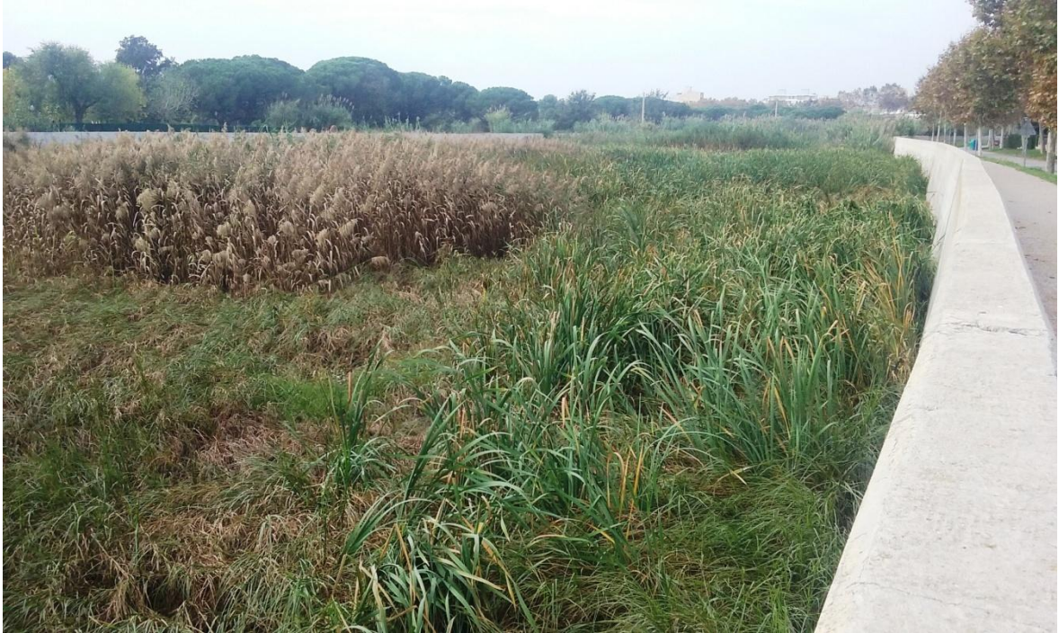
Ejemplo de encauzamiento sin cauce o de cañaveral encauzado. Mar a 100 m aguas abajo
