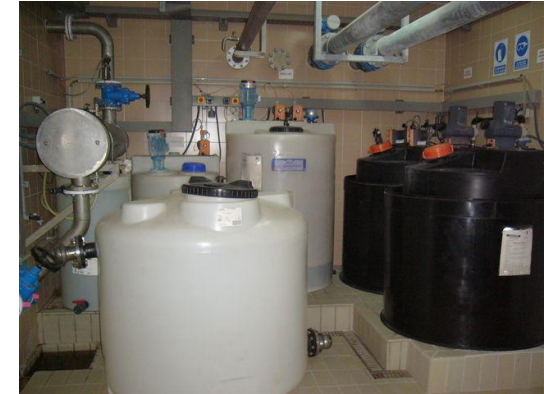
Equip desinfecció amb llum UV i reactius per a tractament físicoquímic i desinfecció d'afinament (per a xarxa de distribució)
